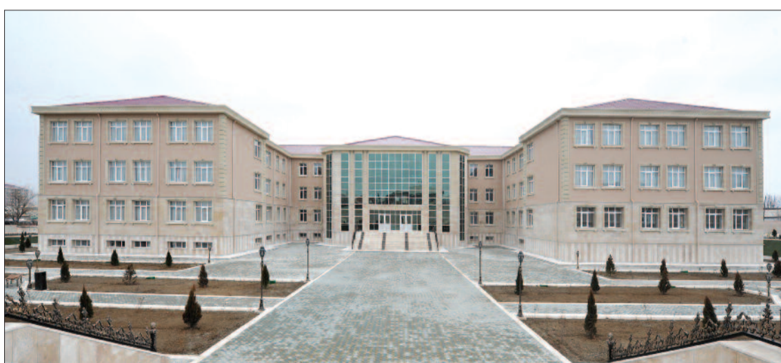
Naxçıvan şəhərində 972 şagird yerlik 10 nömrəli tam orta məktəb
