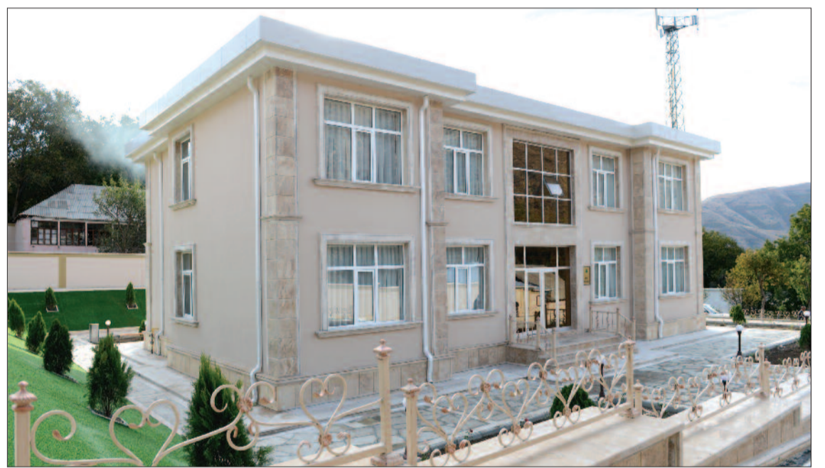
Şahbuz rayonunun Kükü kəndində həkim ambulatoriyası
