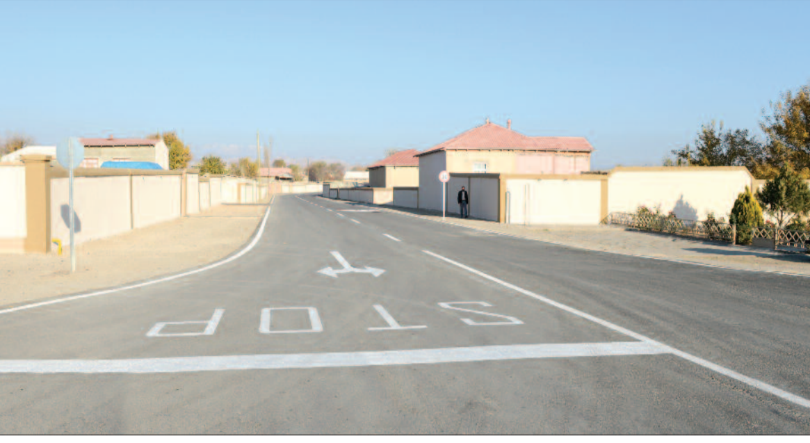
Kəngərli rayonunun Xok kəndində 9,5 kilometr uzunluğunda avtomobil yolu
