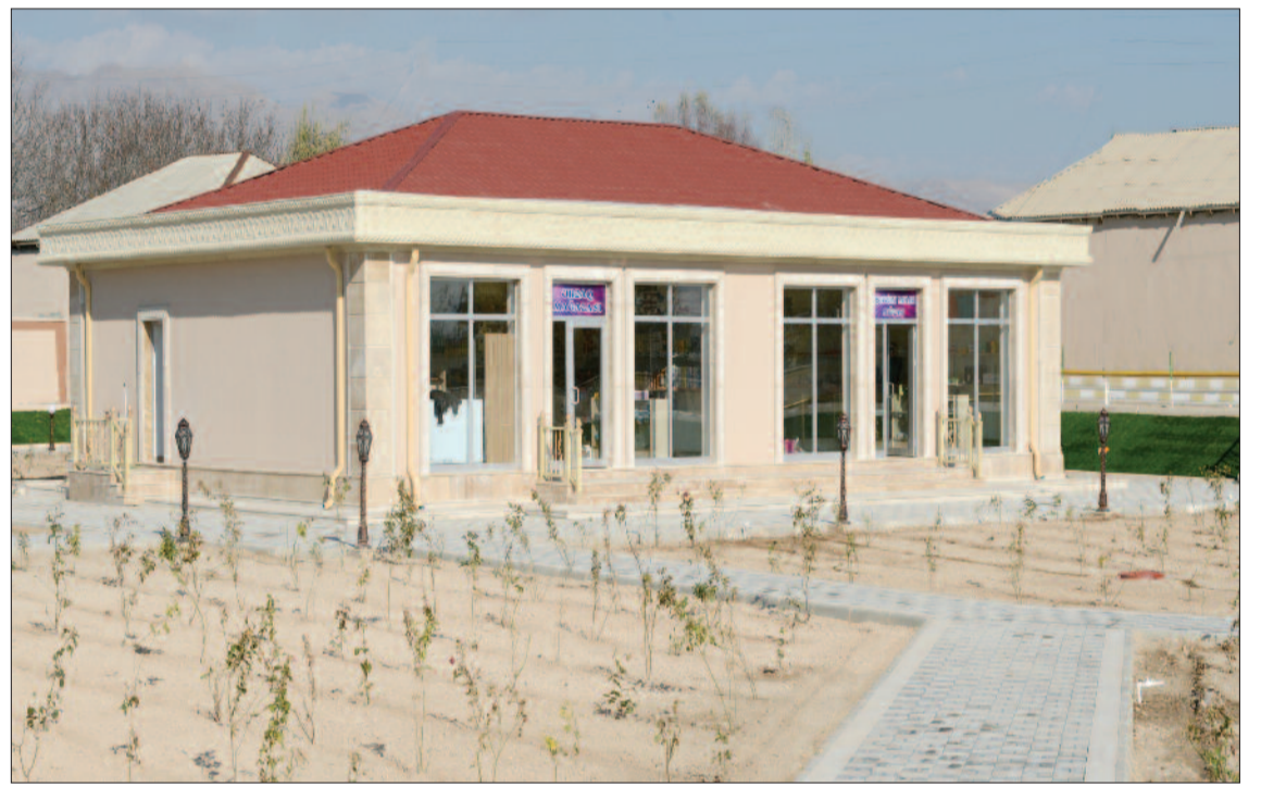
Kəngərli rayonunun Xok kəndində xidmət mərkəzi
