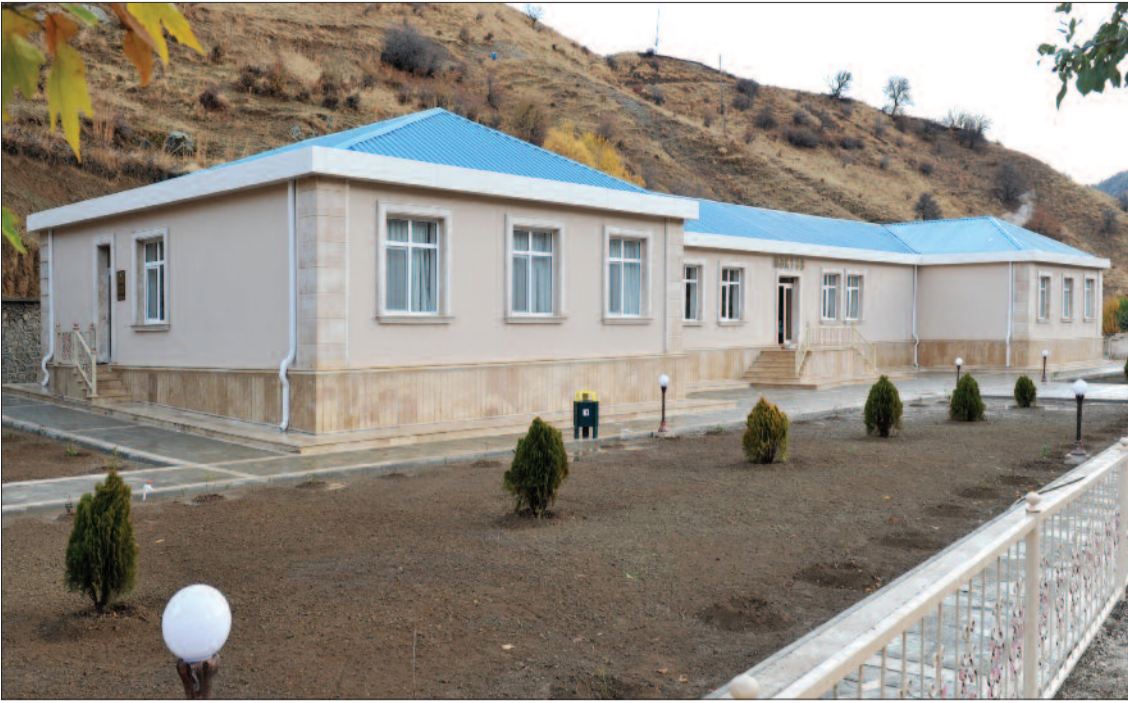
Ordubad rayonunun Nürgüt kəndində 110 şagird yerlik tam orta məktəb
