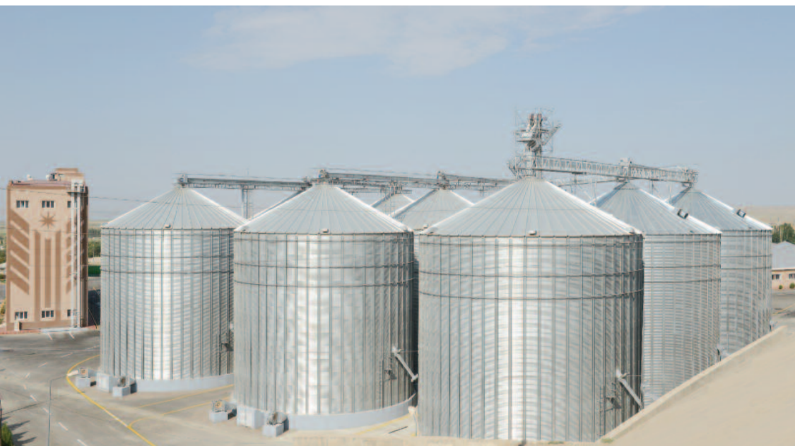
"Naxçıvan Taxıl Məmulatları Sənaye Kompleksi" Məhdud Məsuliyyətli Cəmiyyətinin yeni taxıl anbarları
