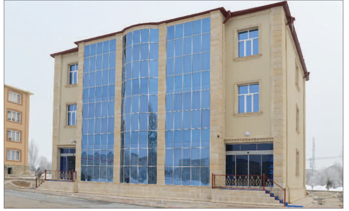
Naxçıvan şəhərindəki hərbi şəhərcikdə xidmət kompleksi
