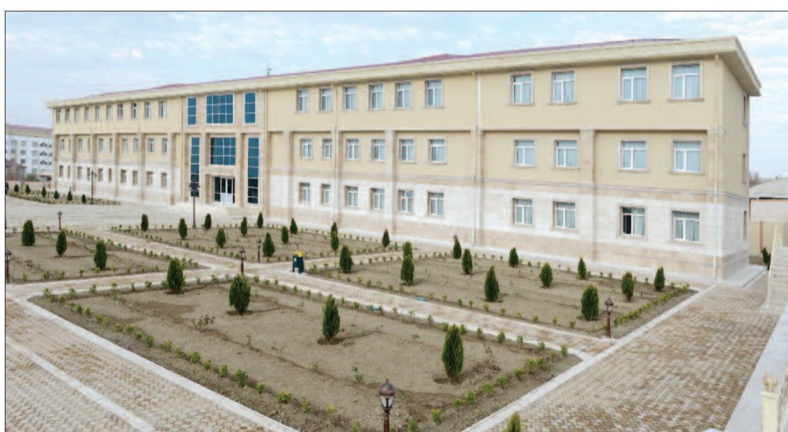
Naxçıvan şəhərində 846 şagird yerlik 16 nömrəli tam orta məktəb
