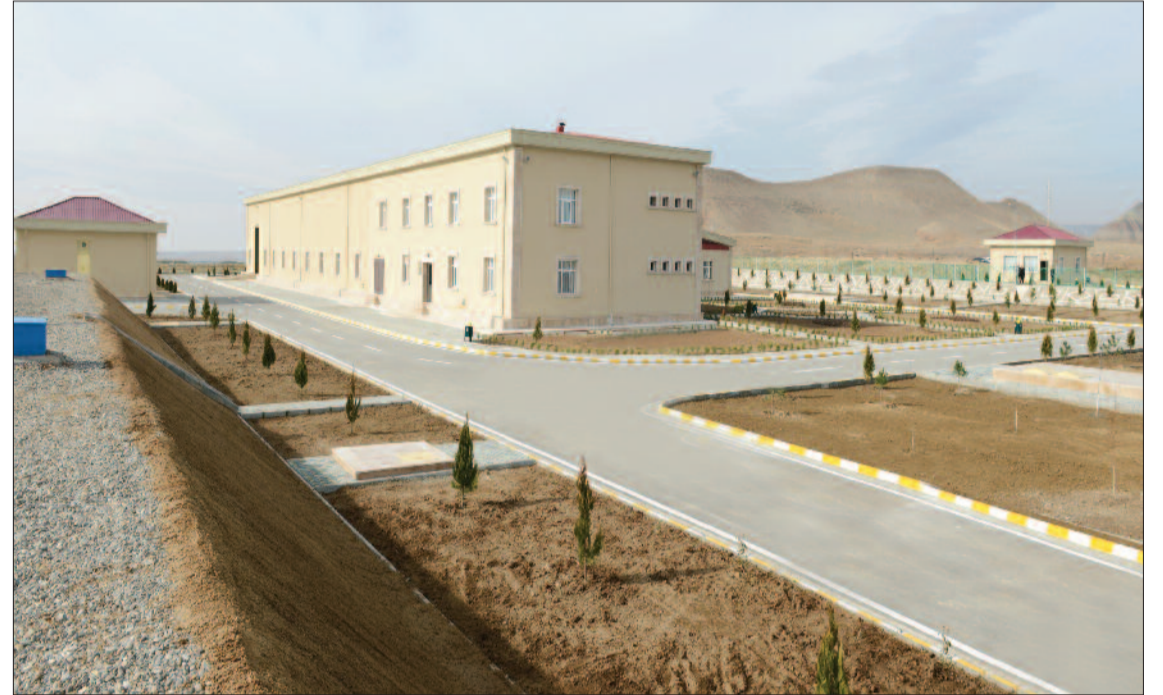
Naxçıvan Şəhər Su Anbarı və Sütəmizləyici Qurğular Kompleksi
