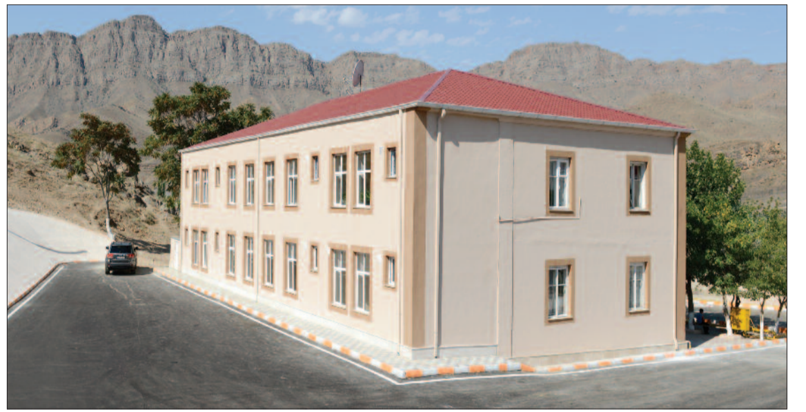
Şərur rayonunun Gümüşlü kəndində yaşayış binası
