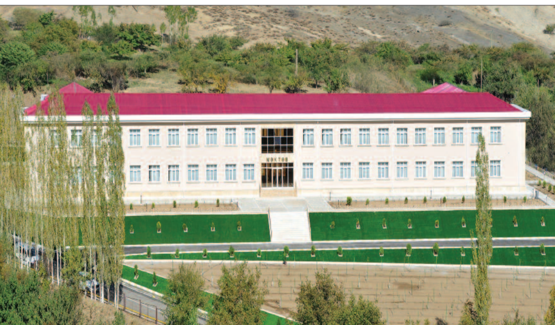
Şahbuz rayonunun Kükü kəndində 198 şagird yerlik tam orta məktəb
